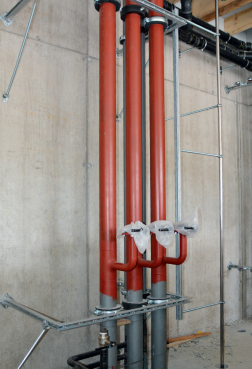
Rohrleitungen nicht isoliert
