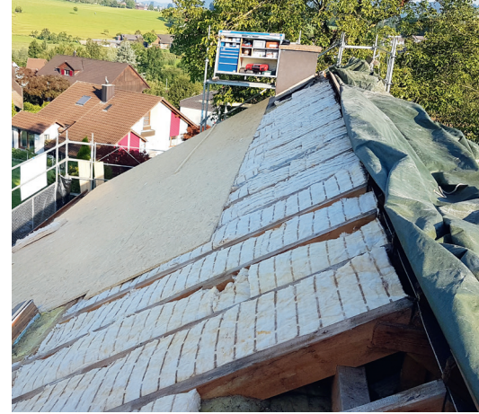
Grobspanplatten OSB auf Sparrenlage mit Zwischensparrendämmung geschraubt
