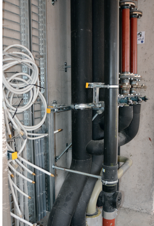
Rohrleitungen isoliert mit swissporAEROFLEX GREEN
