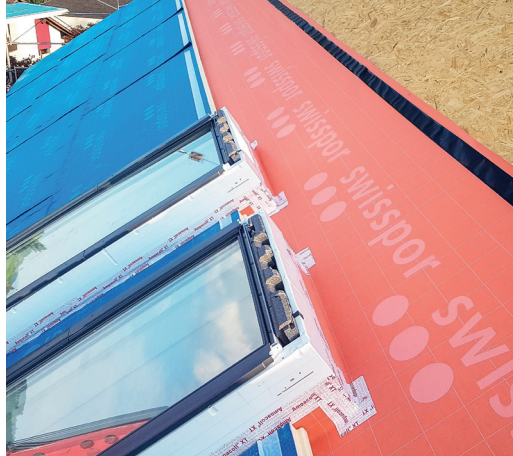
Verlegte swissporTETTO Alu Difuplan Platten mit darunterliegender swissporDampfbremse SD 5
