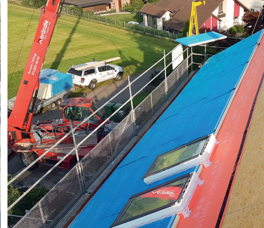
Verlegte swissporTETTO Alu Difuplan Platten mit darunterliegender swissporDampfbremse SD 5
