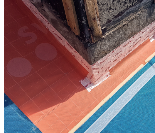
Anschluss der Unterdachbahn an Kamin
