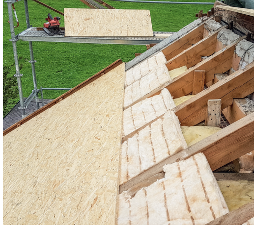
Grobspanplatten OSB auf Sparrenlage mit Zwischensparrendämmung geschraubt
