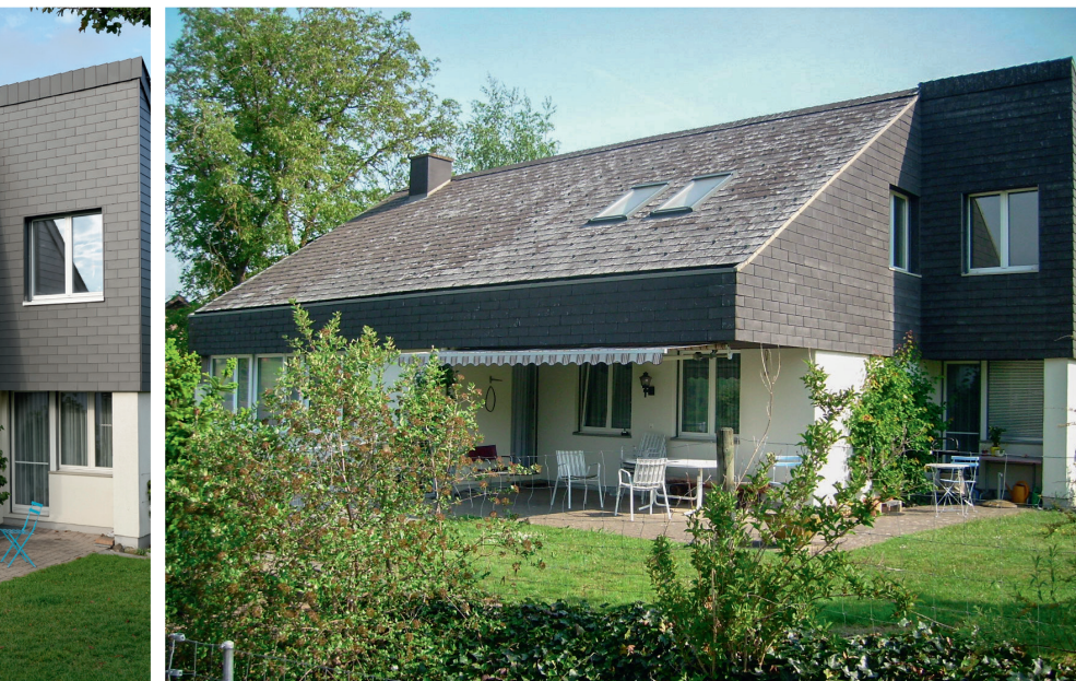
Ansicht vor der Sanierung
